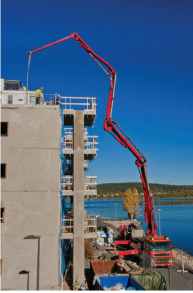
الشكل ١٩ تستعمل بعض المعدات الهيدروليكية في أعمال البناء.
