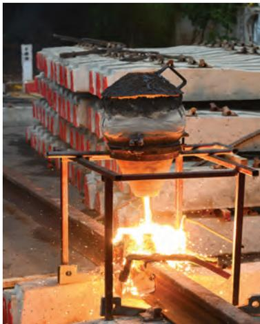
الشكل 13 يستعمل تفاعل الثيرميت في لحام قضبان السكك الحديدية.
