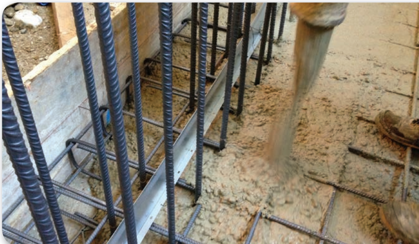
الشكل 28-7 يضاف الحديد إلى الخرسانة؛ لتزويدها بصفات تجعلها قادرة على مقاومة قوى الضغط والشد.
